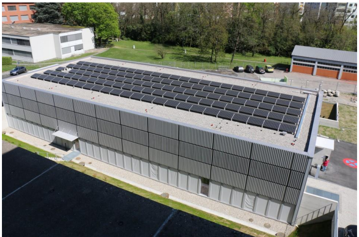
Tetto dello stabile con impianto fotovoltaico
