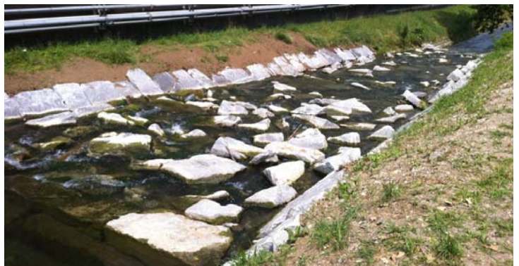
Nuova rampa Cercera sul Laveggio
