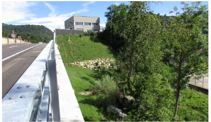
Piantumazioni presso il viadotto Tana
