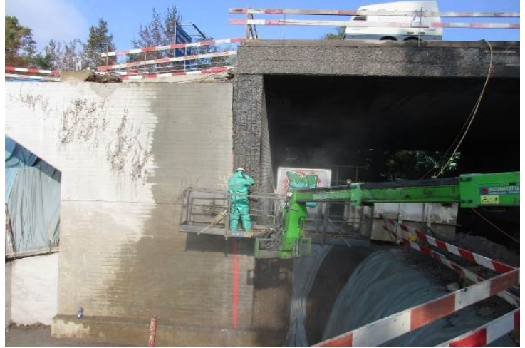
Idrodemolizione per adattamento ponte sul Laveggio
