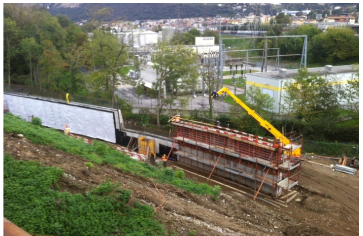
Realizzazione nuovo muro Tana
