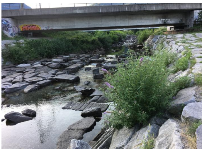
Scala di rimonta per pesci sul fiume Morobbia
