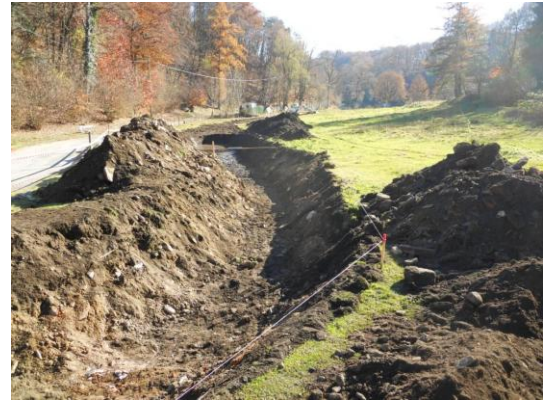
Scavo della trincea
