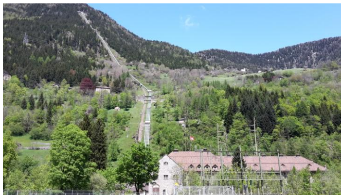
Attuale Centrale FFS + condotte forzate
