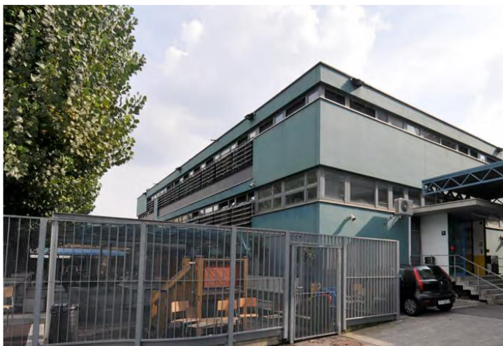
Edificio prima della ristrutturazione
