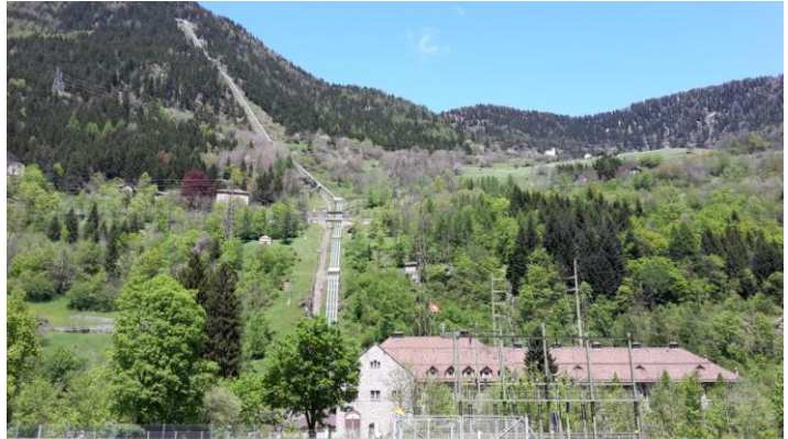
Attuale Centrale FFS + condotte forzate
