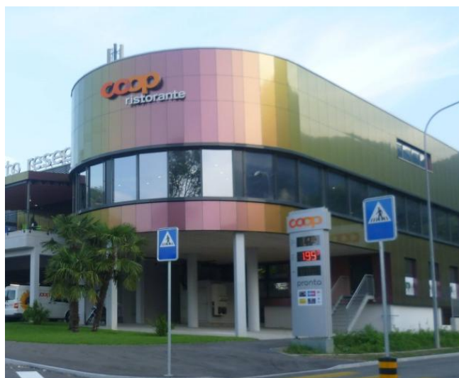
Centro commerciale dopo il risanamento
