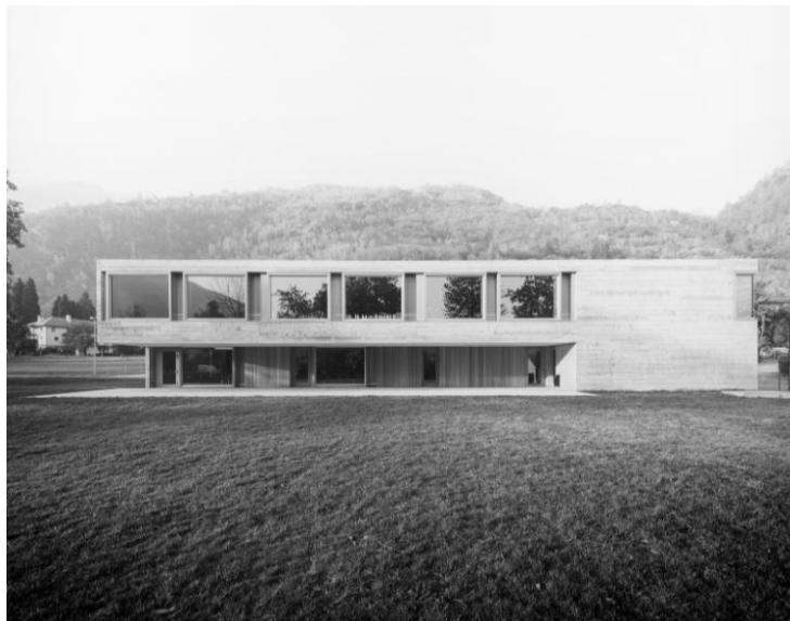
Facciata principale dello stabile
