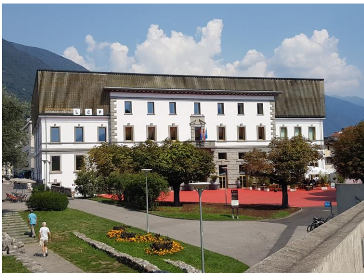
"PalaCinema" dopo il risanamento
